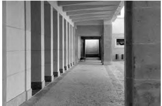
7. Scuola Francisco de Arruda. Portico di collegamento tra il patio centrale e la quota superiore. Foto Laura Castro Caldas & Paulo Cintra.
