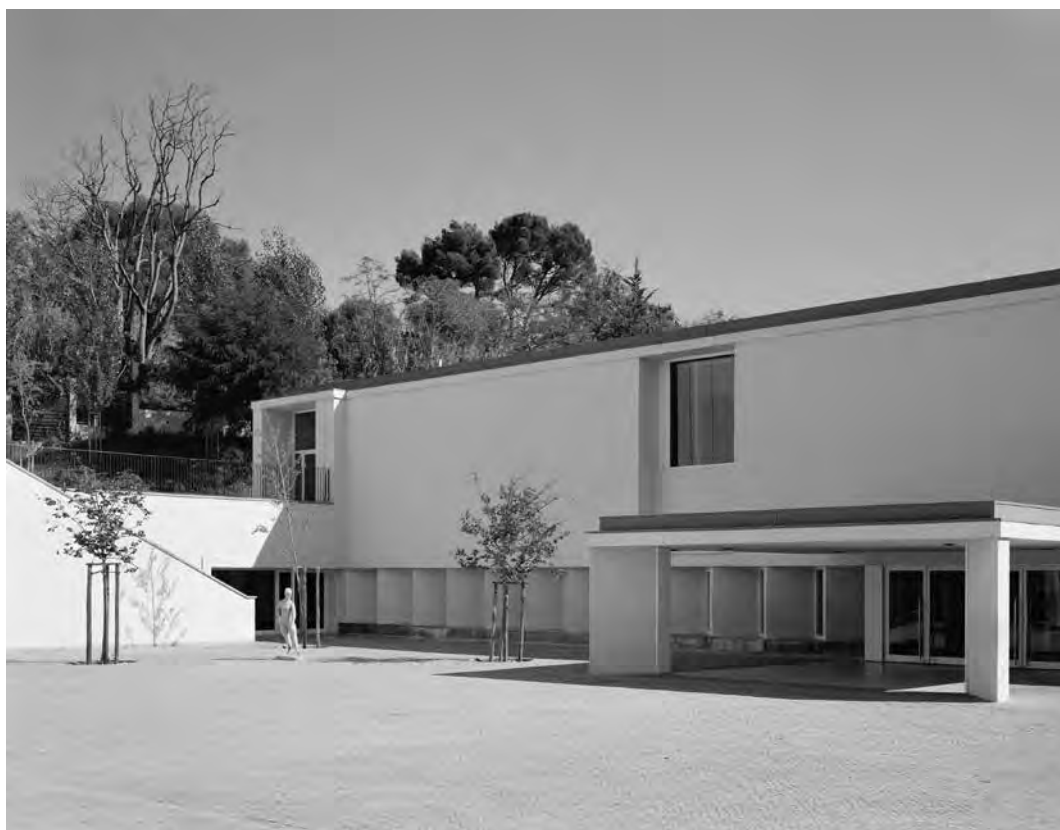
4. Scuola Francisco de Arruda. L'ingresso attraverso il nuovo corpo. Foto André Cepeda.
